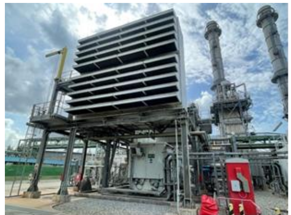
Gas Turbine & Generator (มี 6 Unit)
