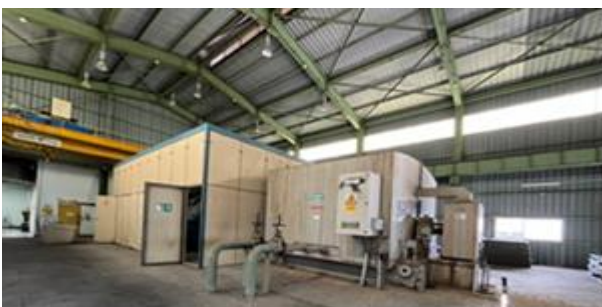
กังหันไอน้ำและเครื่องกำเนิดไฟฟ้า (หยุดเดินเครื่อง)
